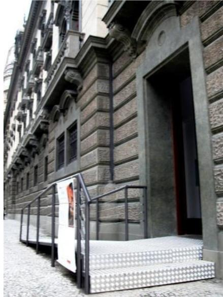
**Figura 02** – Adaptación de rampa accesible en edificios antiguos.
