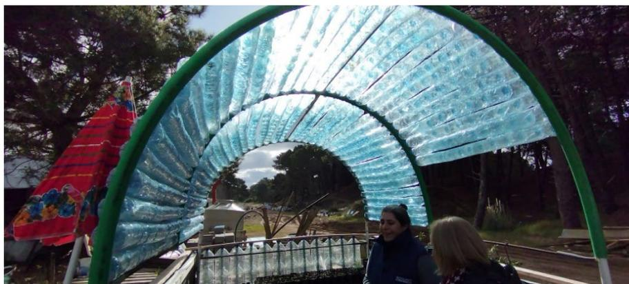
Figura 7. Reuso de botellas de plástico para realizar un techo para el vivero de Reciclando Conciencia
